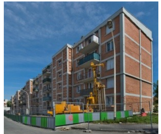
Réhabilitation d'un ensemble de logements © Laurent Mignaux - MEDDTL
